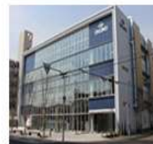
奥野製薬工業株式会社 総合技術研究所 西棟
